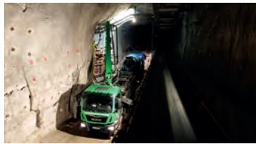
Sanierung eines 600 Meter langen Stollens in Haßmersheim (Baden-Württemberg)
